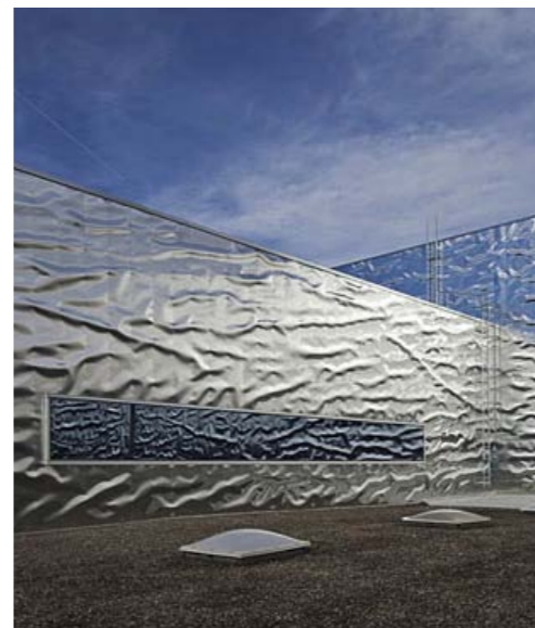
Die Fassade des Logistikkentrums im schweizerischen Spreitenbach erinnert an zerknüllte Verpackungsfolie und bietet eine spannende Optik.
