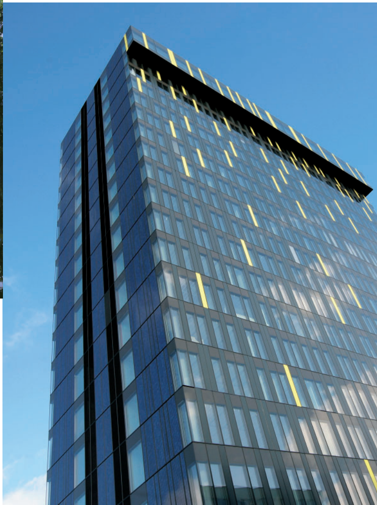
Der Power Tower in Linz – umgesetzt vom Architekturbüro kaufmann | partner – zeichnet sich durch Nachhaltigkeit aus. Pulverbeschichtete Aluminiumprofile sind wichtige Gestaltungselemente in der architektonischen Erscheinung. © www.alufenster.at | Energie AG
