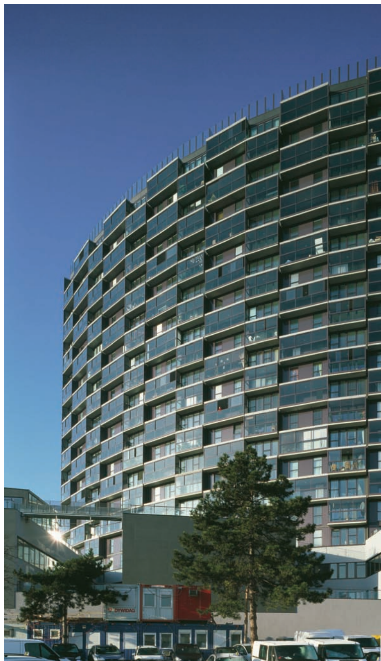
Beim geförderten Wohnbau in der Kundratstraße in Wien hat sich der Bauherr für ein Aluminium-Profilssystem, das die Gemeinschaftsmarke ALU-FENSTER führt, entschieden. © www.alufenster.at | Image Industry
