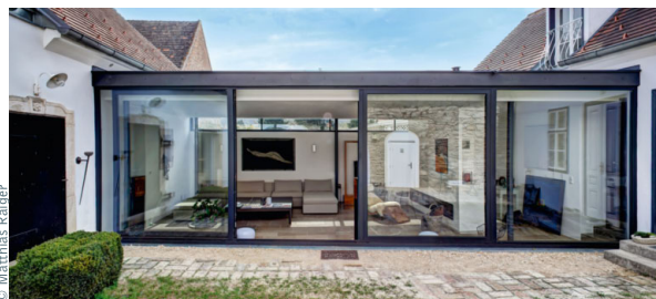
pöt-efh Zubau in Pöttelsdorf . gerner°gerner plus
