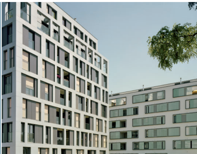
Bei der Wohnhausanlage Attemsgasse wurde erstmals in Österreich bei einem geförderten Wohnbau der hochwertige Werkstoff Aluminium eingesetzt. © Eduard Hueber | archphoto.com
