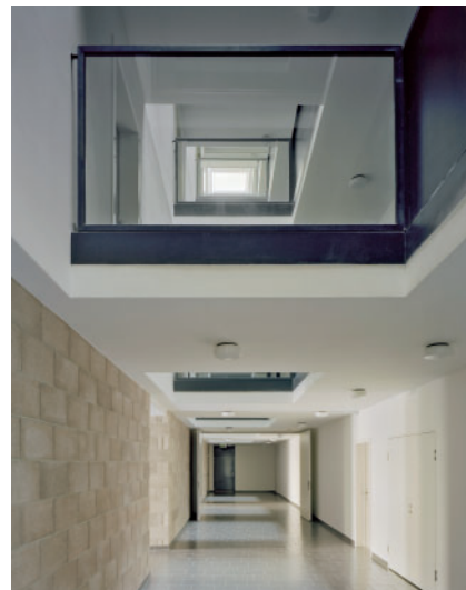
Aluminium und Glas sind die dominierenden Werkstoffe in der Wohnhausanlage in der Attemsgasse in Wien 22. © Eduard Hueber | archphoto.com
