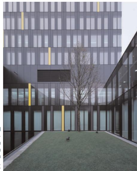
Das ruhige Fassadenbild aus anthrazitfarbenen pulverbeschichteten Aluminiumprofilen und -elementen wird durch ein Muster aus gelben Aluminiumpaneelen aufgelockert.
