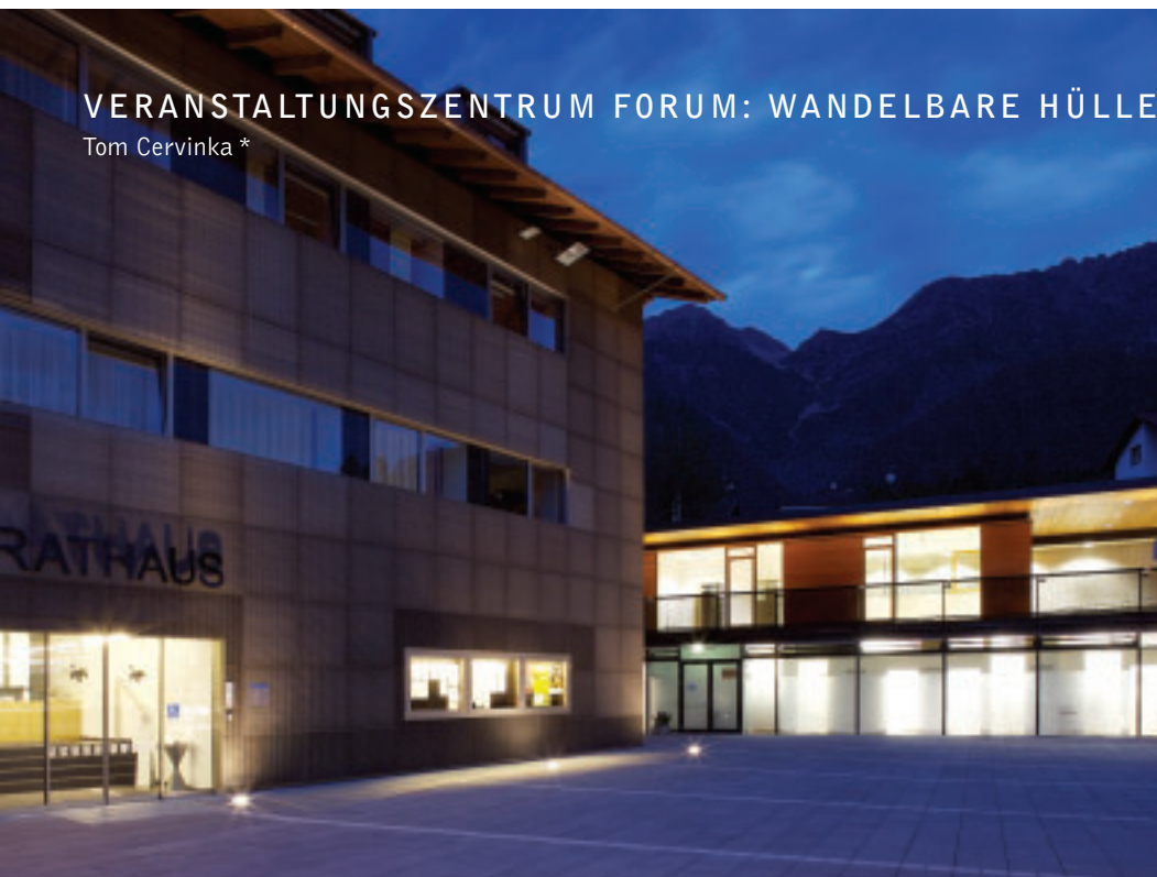
Der Altbestand – das Rathaus – wurde mit einer Alu-Gitter-Fassade versehen und um einen Anbau verlängert. Verschiedene Tages- und Kunstlichtsituationen lassen eine sehr lebendige Fassade entstehen. © Günter R. Wett
